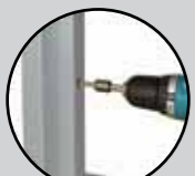
Festing i sidevegger
